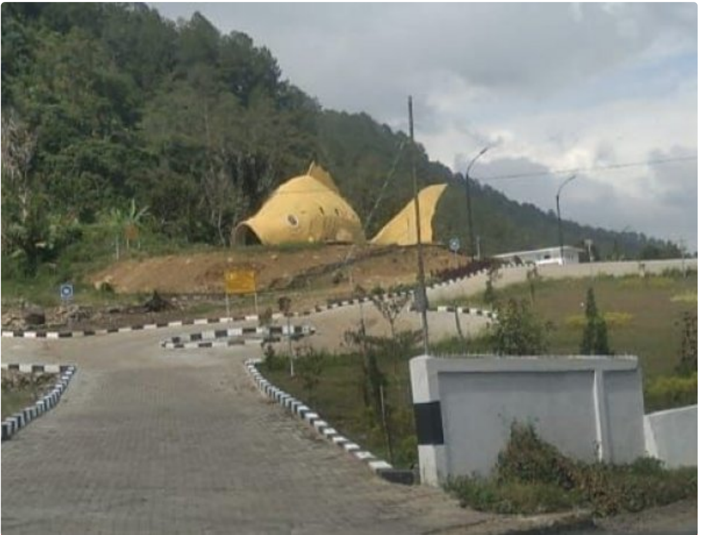
Proyek Pembangunan Ikan Mas Sipolha
